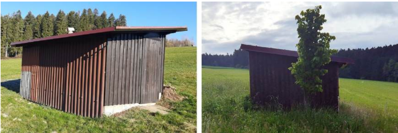
Abb. 13: Ansicht der zur Wasserversorgung gehörenden Pumpstation (links) und der neben der Pumpstation befindlichen Linde (rechts).
