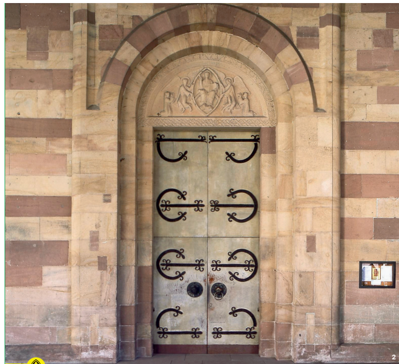
Das Hauptportal der Klosterkirche trägt noch die originalen Beschläge aus der Romanik
