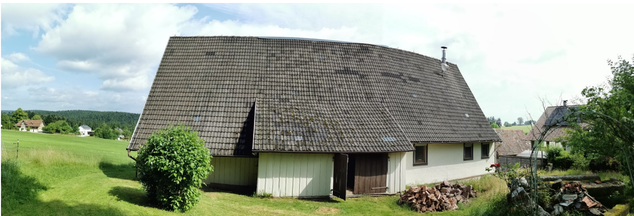
Abbildung 5: Ansicht des Abbruchgebäudes in nördliche Richtung. Aufnahme vom 23.06.2025.
