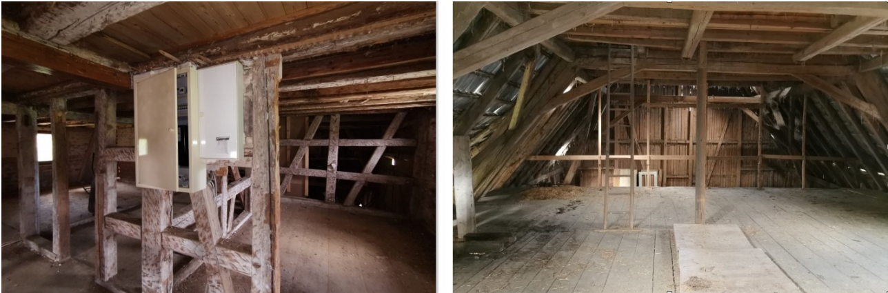
Abb. 14: Ansicht aus dem Gebäudeinneren: Zwischengeschoss (rechts) und Dachboden der Scheune (rechtsl).
