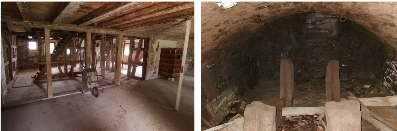
Abb. 13: Ansicht aus dem Inneren des Gebäudes, auf dem rechten Bild ist der Kellerraum abgebildet.
