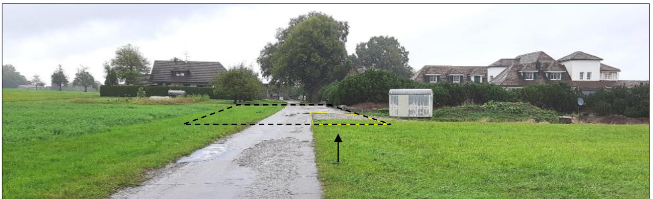
Ansicht aus Süden auf den Teilbereich 1, während der Bauausführung im Oktober 2024. Pfeil / gelb umrandet Lage der zusätzlichen Flächenversiegelung (Wegerweiterung), im Foto teils bereits als Schotterfläche ausgebildet
