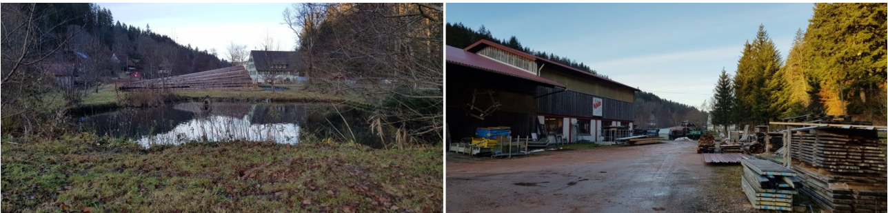
Abb. 4: Links der im Norden des Geltungsbereichs gelegene angelegte Teich auf FlSt. 51/5, das Holzlager im Hintergrund gehört zum benachbarten Betrieb und liegt außerhalb des geltungsbereichs. Rechts das auf FlSt. 51/1 befindliche Hauptgebäude mit Materiallagerflächen (Fotos vom 07.12.2022)
