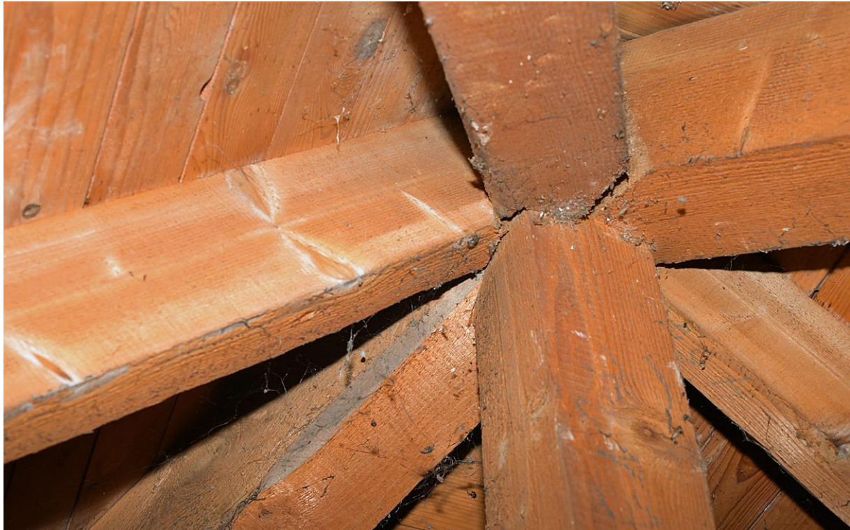
Abb. 3: Turmspitze im Maba-Aufzugsturm mit Spinnweben.
